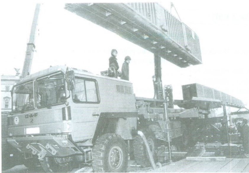
Foto 3: Het plaatsen en koppelen van de Vorbauträger Innenabschnitt. Let op de reeds uitgeschoven gekoppelde delen.
